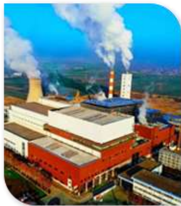
垃圾焚烧厂脱硝
